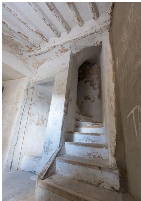
8. Puerta de acceso a la sala del coro (izquierda de la fotografía). Puerta de acceso al cuerpo superior de la torre (derecha de la fotografía): Escalera recta y después helicoidal (detalle de peldaños con mampelranes de madera y bóveda de medio cañón).
