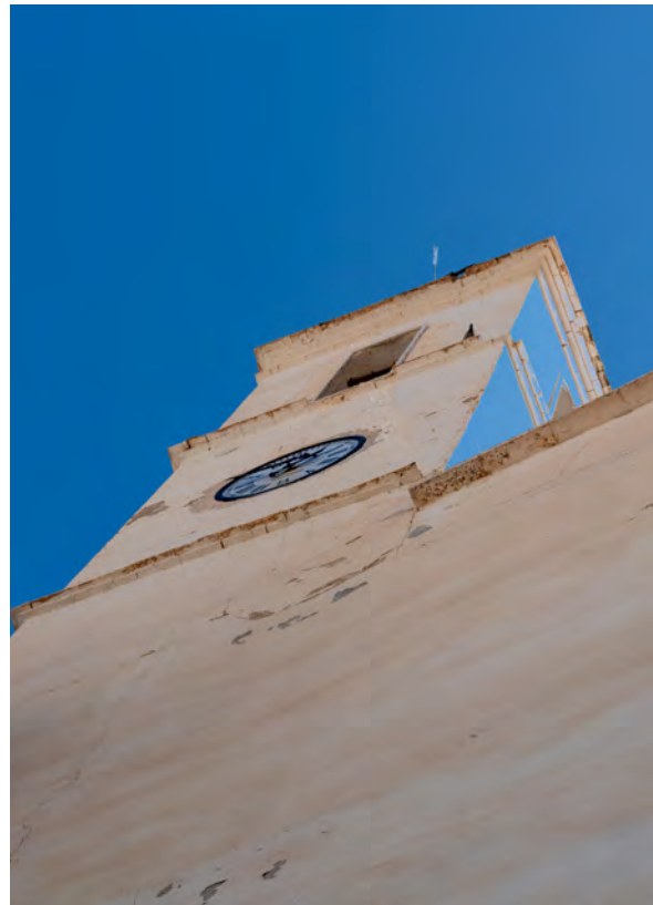
22. Detalle del cuerpo del campanario y las tres cornisas o impostas de la torre.
