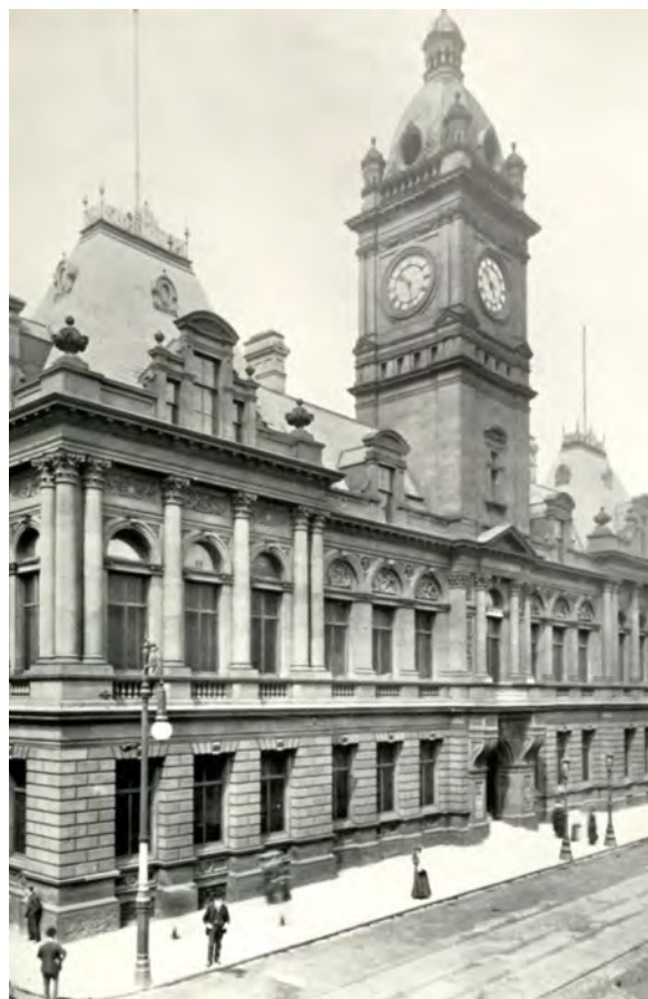
Figura 4. Ayuntamiento de Sunderland (Inglaterra). Hacia 1890. Fuente: https://northeastlore.com/ .
