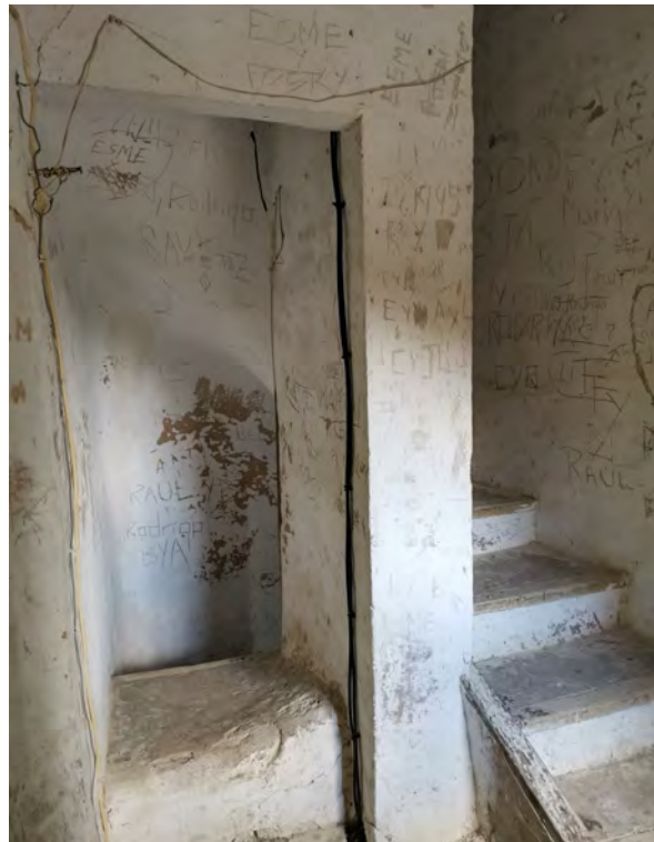
7. Entrada a la sala del coro y subida al cuerpo de la torre (podemos ver dintel y bóveda de medio cañón en la escalera de acceso a la sala del coro y escalera con mampelranes que ascienden al cuerpo superior de la torre).
