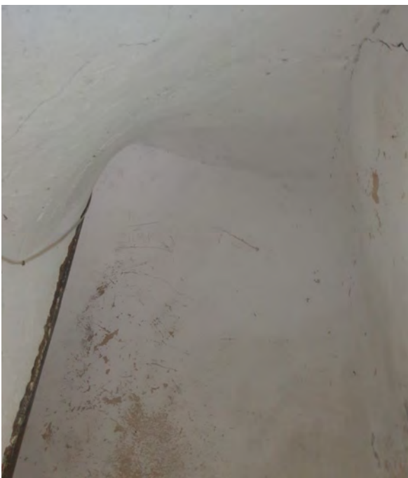
10. Bóvedas de medio cañón en la subida helicoidal de la escalera.
