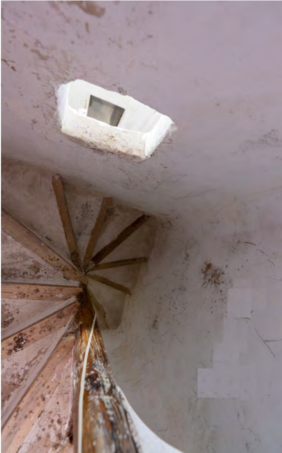
9. Subida helicoidal a la torre, máchón, mamperlanes y tragaluz.
