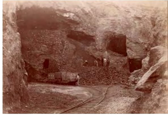
Figura 9. Labores de explotación en la mina Mulata de Bédar y punto de partida del ramal norte de ferrocarril de Chávarri. Hacia 1898. Col. Juan Antonio Soler Jódar.
