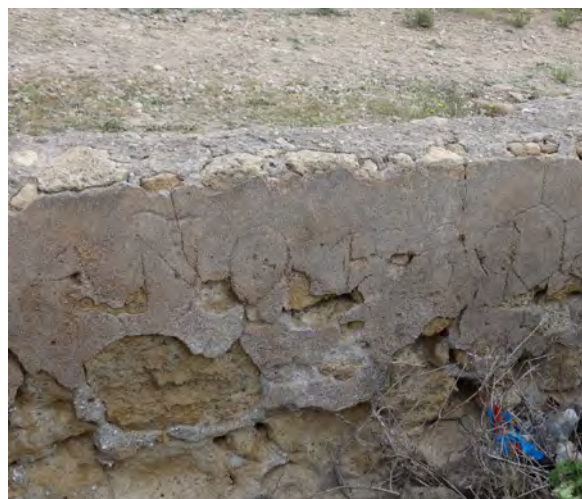
Fecha grabada en muros de las instalaciones de las baterías situadas en el cerro que cubre el puerto ("Año 1939"). Los trabajos en las instalaciones de las baterías se prolongaron hasta el final de la guerra e, incluso, después de ella. Foto: Antonio Salvador Callejón Rubio.
