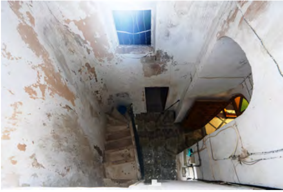
4. Arco de entrada, sala inferior de acceso a la torre y subida, por escalera recta pegada al muro, al cuerpo de esta.
