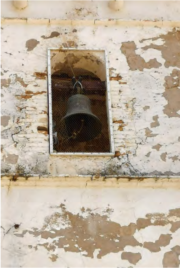
17. Campanario. Campana N desde el exterior (detalle de las 2 cornisas con ladrillos sentados y entrecruzados, la de abajo, y una fila de ladrillos tumbada y colocada a lo ancho en la cornisa que esta sobre los arcos del campanario. El arco exterior del campanario es de ladrillo macizo).
