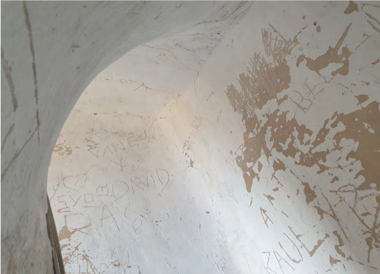
10. Bóvedas de medio cañón en la subida helicoidal de la escalera.
